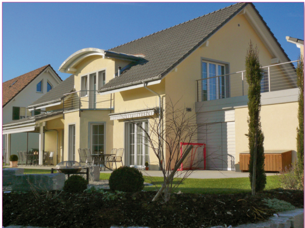
Dem Haus der Familie Huber sieht man nicht an, dass nachträglich das Gebäudeautomations-System Sigmalon installiert wurde. Denn Sigmalon arbeitet mit der bestehenden Elektroinstallation.
